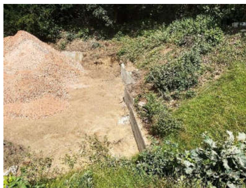
Abbildung 4 Nördliche Geländekante bei Abbruch, Juli 2020
