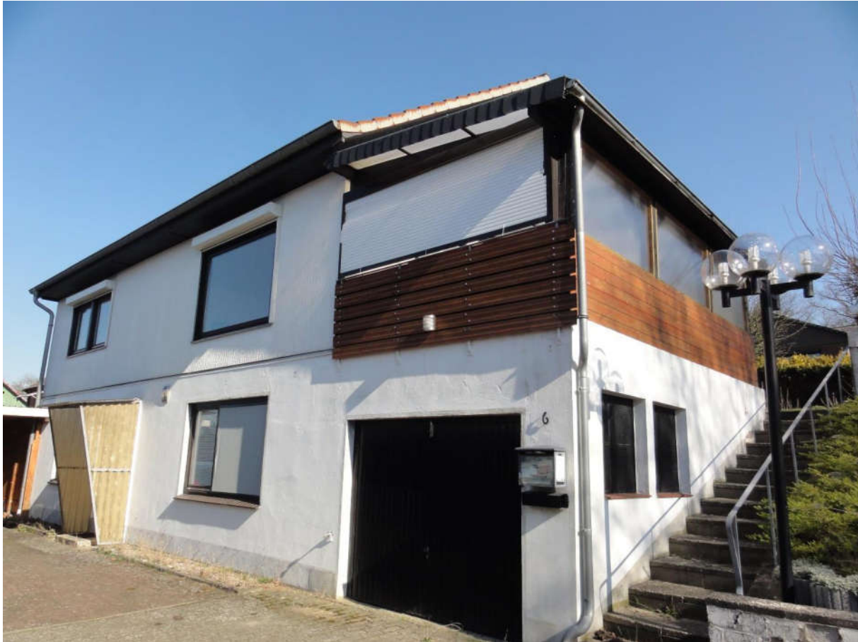
Abbildung 5: Gebäude im Osten des Plangebietes mit Quartierpotenzial für Fledermäuse
